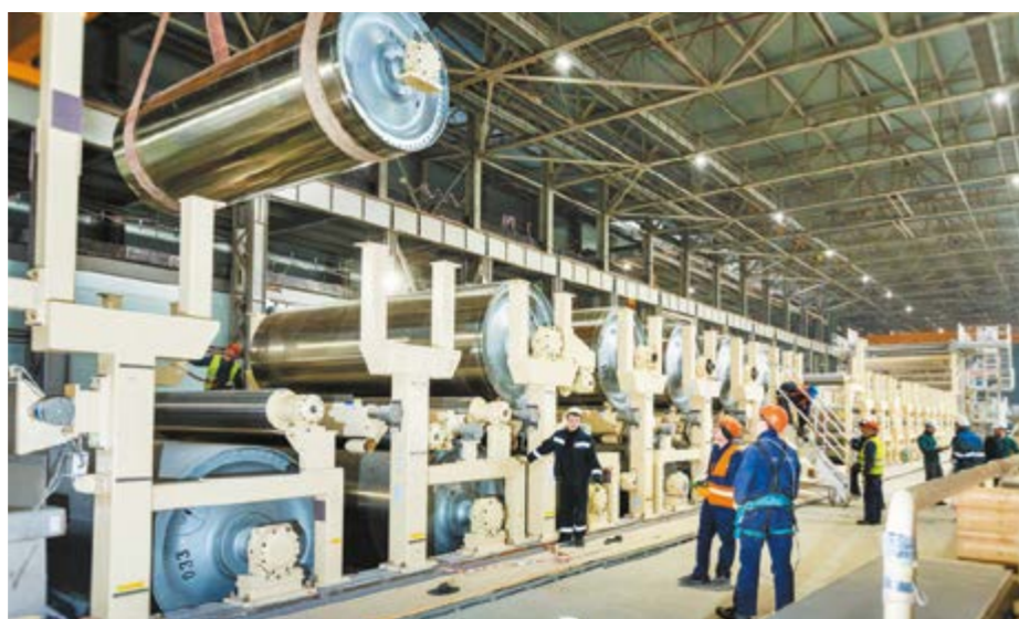
■ Монтаж новой бумагоделательной машины на Сеgezском ЦБК
